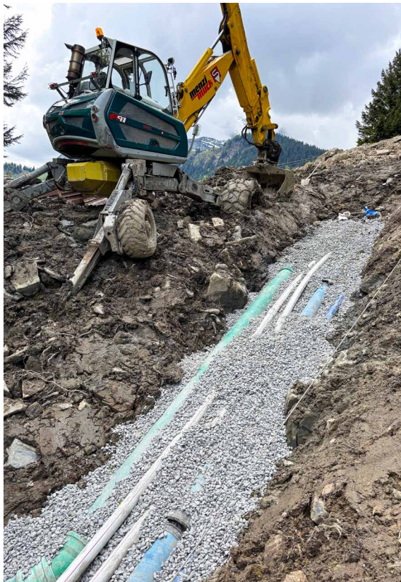
Im steilen Gelände mit Hangwasser und lehmigen Boden kam ein Menzi Muck zum Einsatz.
